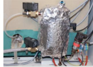
Парогенератор, система регулирования влажности
